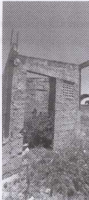
Figura 1 – Poço 01 – Abrigo do poço não concluído.
