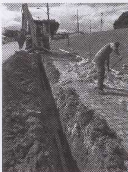
Figura 3 – Abertura de valas e implantação da rede de distribuição de água de reforço.
