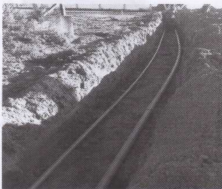
Figura 5 – Adutoras dos poços.
