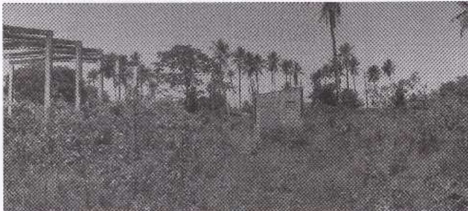
Figura 2 – Poço 02 – Abrigo do poço não concluído.
