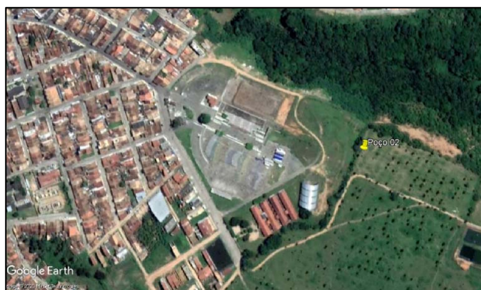
LOCALIZAÇÃO DO ABRIGO - POÇO 2 LOTEAMENTOS SÃO JORGE E SÃO PAULO, ESTÂNCIA/SE (PRÓXIMO AO FERRÓDROMO)
