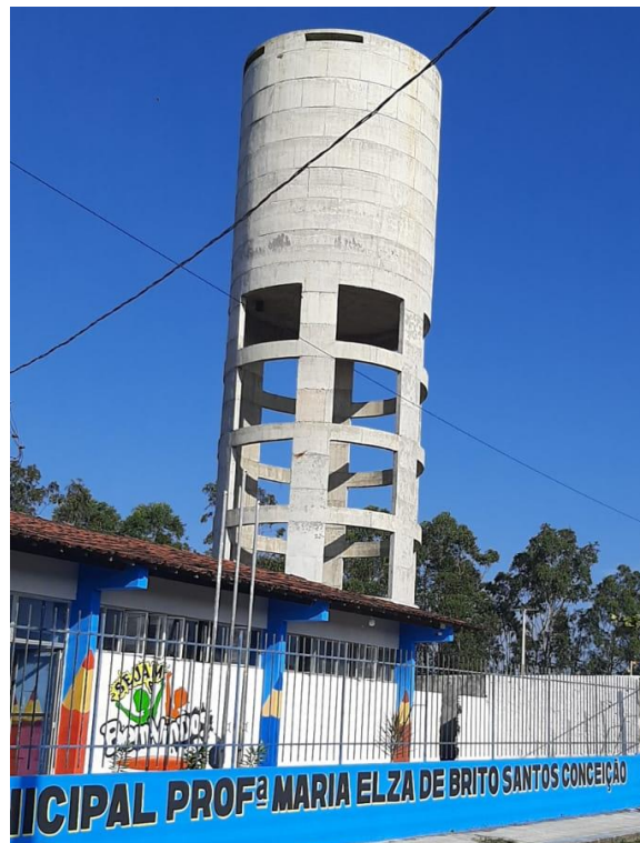
Figura 6 – Estrutura do reservatório elevado concluída.
