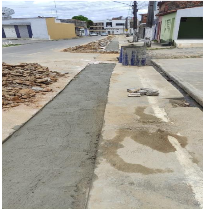
Figura 4 – Recomposição da pavimentação.
