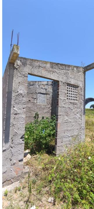
Imagem 1: Poço 01 – Abrigo do poço não concluído.
