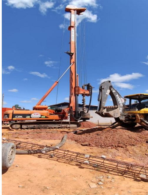
Imagem 6: Execução das estacas hélices.
